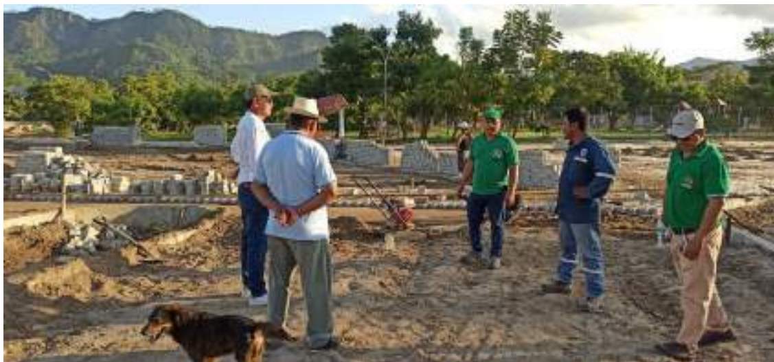
Imagen 7 - Trabajos de Enlosetado de la Plaza 6 de Agosto (Barrio Los Sauces) - Gestiones con FONPLATA y FPS
