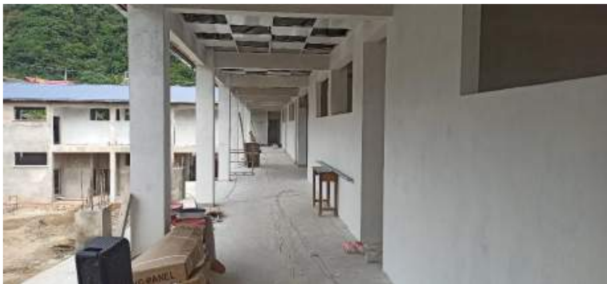
Imagen 13 - Vista del interior del Bloque de Aulas de la UE Gualberto Villarroel D1
