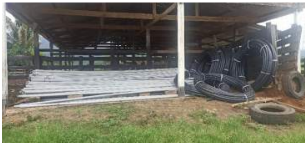
Imagen 4 - Mej. Sistema de agua D6 con la dotación de tanques de agua, tuberías y accesorios
