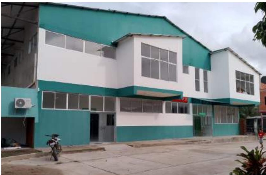
Imagen 9 - Imagen de la Ampliación del Hospital Municipal de Rurrenabaque (Emergencias e Internación)
