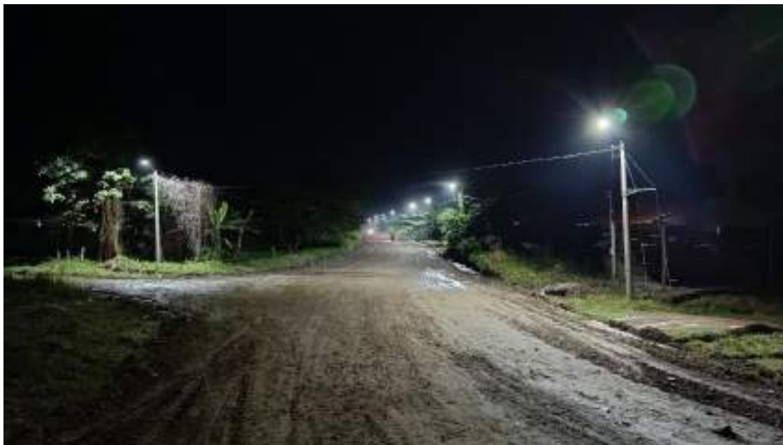
Imagen 6 - Nuevas Laminarias Viales LED en calles y Avenidas (Barrio Isla Grande - D2)
