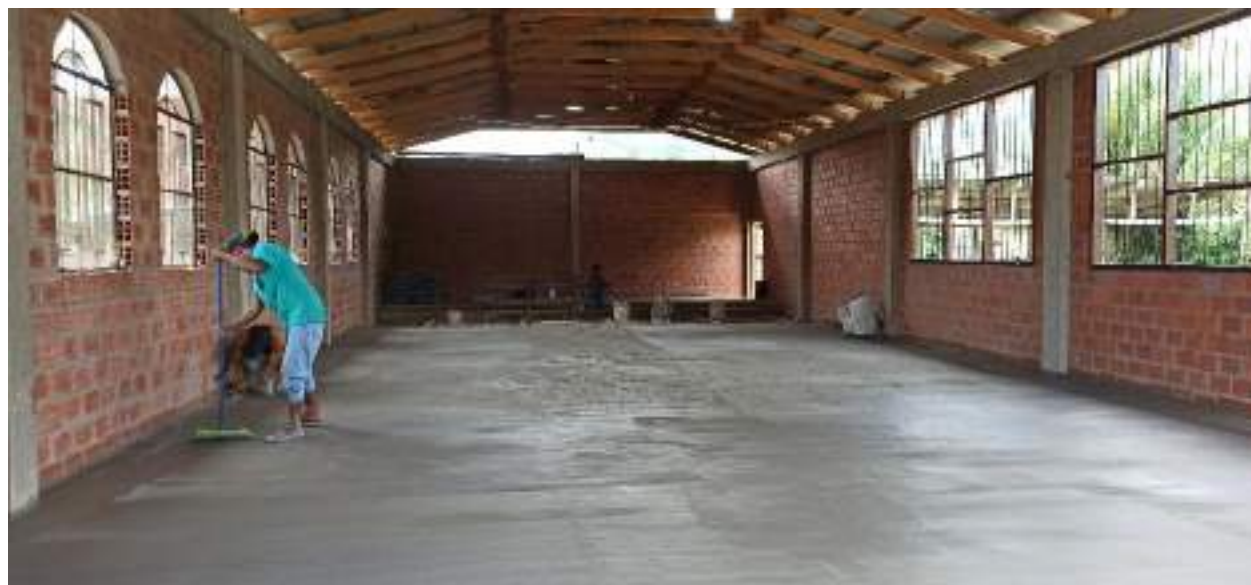
Imagen 14 - Centro de Capacitación Barrio San Antonio D2
