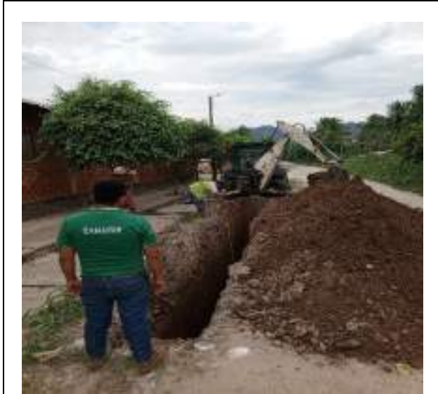
FIG 25. AMPLIACIÓN DE RED MATRIZ EN LA CALLE ABAROA FINAL Y MAGDALENA AMUTARI. BARRIO AMBAIBOS
