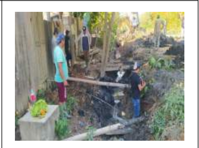
FIGURA 24: TRABAJOS DE EXCAVACIÓN Y POSTERIOR REPARACIÓN DE ROTURAS DE CAÑERÍAS DE AGUA EN EL BARRIO LOS AMBAIBOS.
