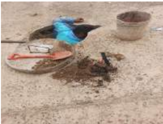
FIGURA 9: TRABAJOS DE LIMPIEZA EN ALCANTARILLADO SANITARIO EN EL BARRIO LOS PENOCOS
