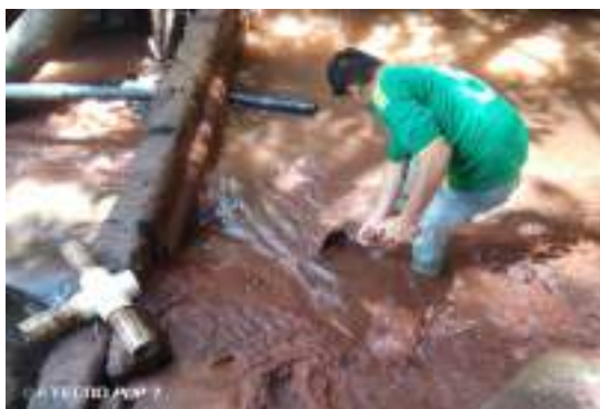
FIGURA 11: TRABAJOS DE LIMPIEZA, DESARENADO DE TOMA SANJON.
