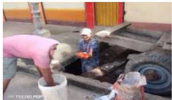
FIGURA 12: TRABAJOS DE LIMPIEZA EN ALCANTARILLADO SANITARIO EN CALLE 18 DE NOVIEMBRE.
