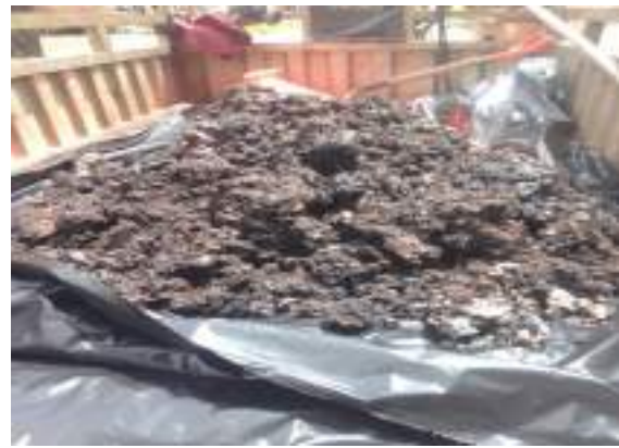
FIGURA 10: RETIRO DE SEDIMENTOS, GRASAS E IMPUREZAS EN LAS REDES DE ALCANTARILLADO SANITARIO CALLE COMERCIO.
