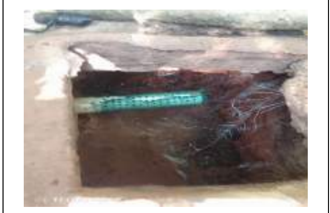
FIGURA 22: TRABAJOS DE LIMPIEZA, DESARENADO, DESRAIZADO EN LA TOMA EL CHORRO, ESTO POR LAS LLUVIAS CAÍDAS EN LA POBLACIÓN.
