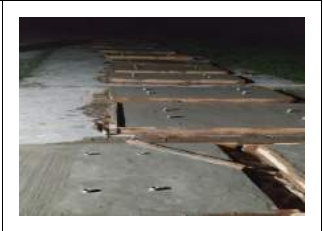
FIGURA 20: TRABAJOS DE HORMIGONADO DE TAPAS DE ALCANTARILLADO SANITARIO, LAS CUALES SERÁN REEMPLAZADAS POR LAS NUEVAS O LAS QUE SE ENCUENTRAN YA CON DETERIORES EN LAS CALLES DE RURRENABAQUE.
