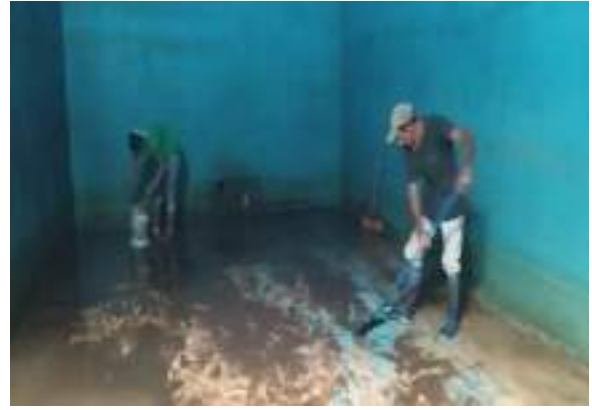
FIGURA 14: TRABAJOS DE LIMPIEZA Y LAVADO DE TANQUE DE ALMACENAMIENTO DE LA TOMA EL CAMUY.
