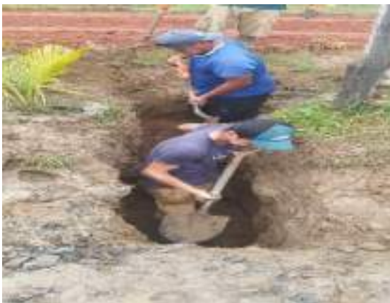
FIGURA 17: TRABAJOS DE EXCAVACIÓN PARA CORTE DE INSTALACIONES CLANDESTINAS EN EL BARRIO DE SANTA ROSITA.
