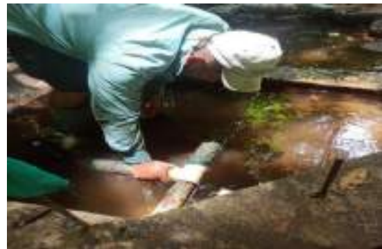
FIGURA 8: TRABAJOS DE LIMPIEZA, DESARENADO DE TOMA RETIRO.
