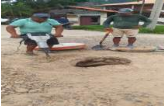
FIGURA 15: TRABAJOS DE CORTADO Y RETIRO DE MATERIAL FRAGMENTADO Y NIVELACIÓN PARA FIJAR LA NUEVA TAPA DE ALCANTARILLA.
