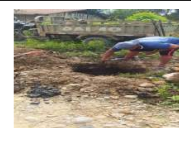
FIGURA 19: TRABAJOS DE MANTENIMIENTO, LIMPIEZA DE RED MATRIZ EN LAS CÁMARAS DE INSPECCIÓN EN LE BARRIO LA SIYAYA, ESTO POR OBSTRUCCIÓN EN LA RED PRINCIPAL,
