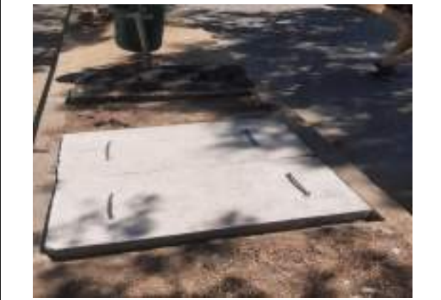
FIGURA 21: TRABAJOS DE CAMBIO DE TAPAS DE HORMIGÓN EN LA CALLE COMERCIO Y ANICETO ARCE.
