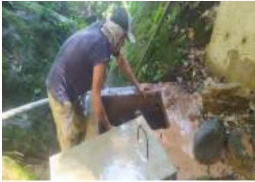
FIGURA 5: TRABAJOS DE LIMPIEZA, DESARENADO DE TOMA EL CAMUY, POR CAÍDAS DE LLUVIAS Y ARRASTRE DE MATERIAL LO CUAL COLMATO TODOS LOS ATAJADOS.
