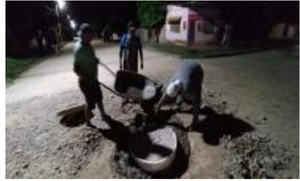
FIGURA 16: TRABAJOS DE REPOSICIÓN DE CARPETA DE HORMIGÓN EN LA CALLE BUSCH, CAMBIADO DE TAPA NUEVA Y NIVELACIÓN DE CARPETA DE HORMIGÓN.
