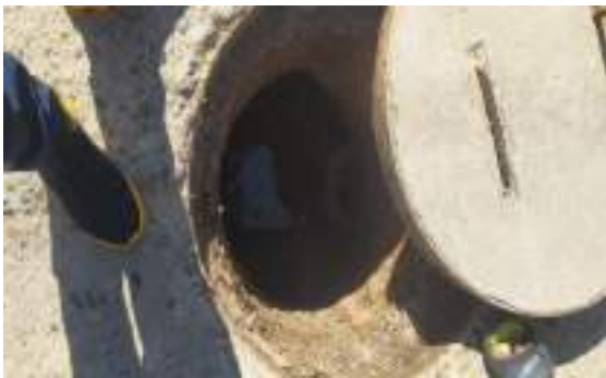
FIGURA 7: LIMPIEZA Y MANTENIMIENTO DE RED DE ALCANTARILLADO SANITARIO EN CALLE COMERCIO.
