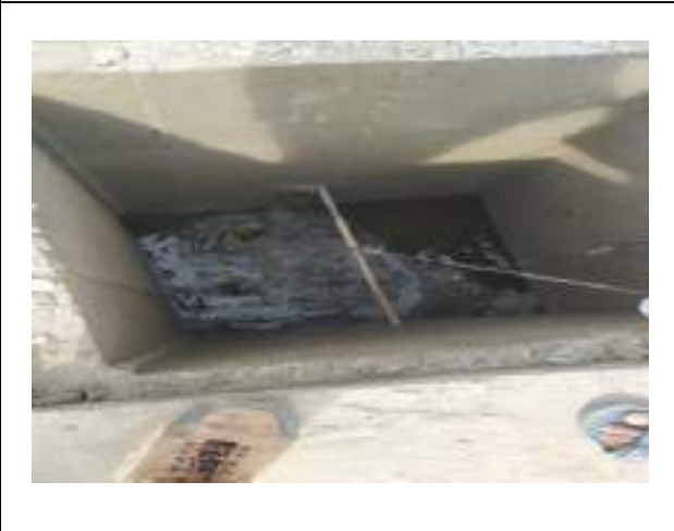
FIGURA 23: LIMPIEZA DE CÁMARAS DE INSPECCIÓN, DANDO ASÍ SOLUCIONES PARA LIBERAR LA OBSTRUCCIÓN DE LA CALLE BENI Y ASÍ LIBERAR LOS SEDIMENTOS U OTROS CONTAMINANTES.
