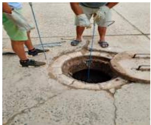
Figura 6: ALCANTARILLADO SANITARIO CON VARILLAS PLAZA PRINCIPAL.
