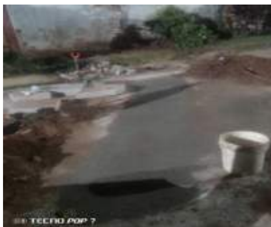
Figura 21: REPOSICION DE PAVIMENTO DE H°S° REDDE ALCANTARILLADO SANITARIO U.E. GUALBERTO VILLARROEL
