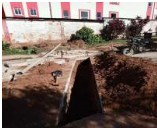
Figura 19: EXCAVACION PARA EL PROYECTO DE RED ALCANTARILLADO SANITARIO U.E. GUALBERTO VILLARROEL
