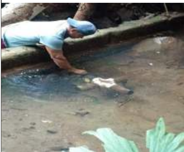
Figura 5: LIMPIEZA Y MANTENIMIENTO TOMA "SANJON"
