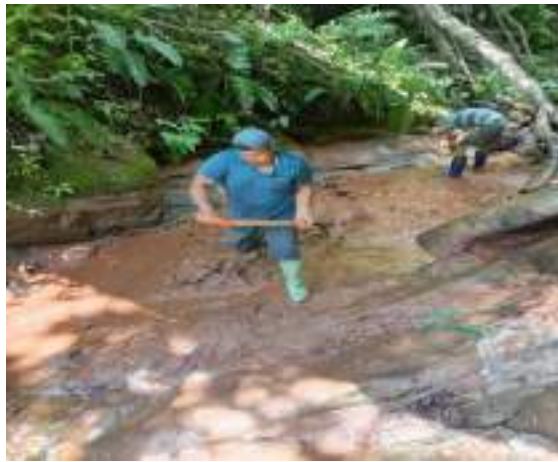
Figura 9: MANTENIMIENTO Y DESARENADO TOMA "SANJON"
