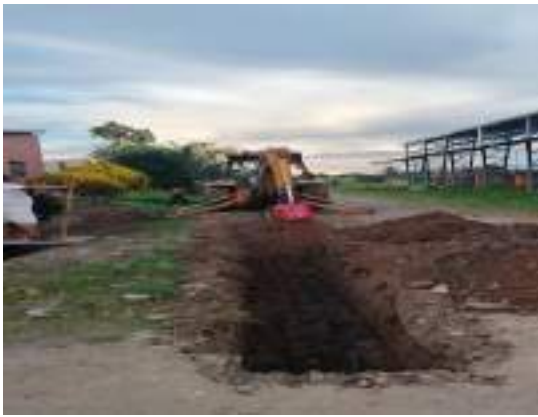
Figura 17: AMPLIACION DE RED MATRIZ EN "LOS AMBAIBOS"
