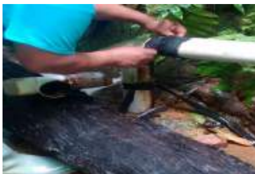
Figura 13: MANTENIMIENTO TOMA "SANJON".
