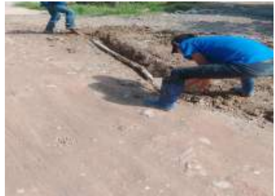
Figura 12: REPARACION DE LA RED DE AGUA POTABLE "EL CERRITO".
