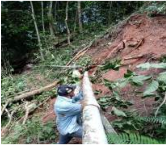
Figura 1: REPARACION DE LA RED ADUCCION TOMA "EL CHORRO"
