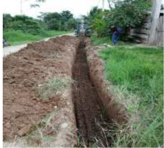
Figura 2: AMPLIACION DE LA RED DE AGUA POTABLE EN "LOS CEDROS"
