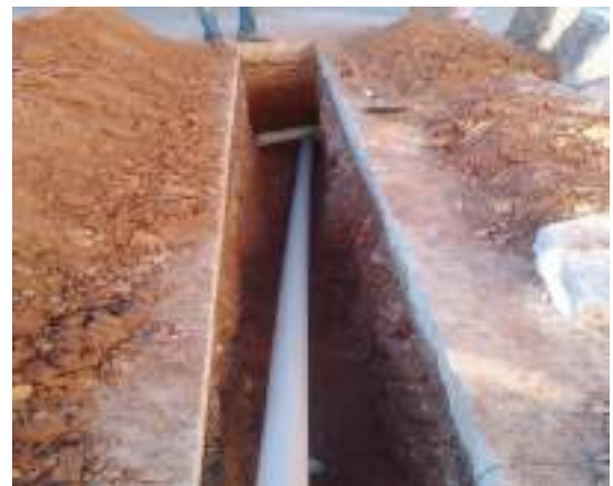
Figura 20: INSTALACION DE TUBERIA DE 4" PARA LA RED DE ALCANTARILLADO SANITARIO U.E. GUALBERTO VILLARROEL
