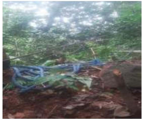
Figura 10: TRABAJO DE EMERGENCIA TOMA "EL CHORRO".
