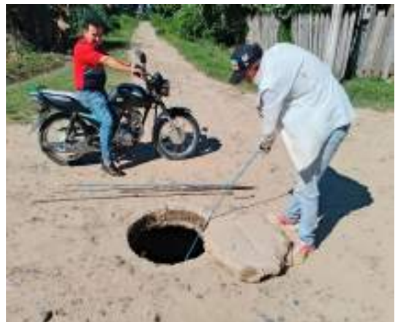
Figura 4: TRABAJO DE ALCANTARILLADO SANITARIO CON VARILLAS EN BARRIO "VILLA LOURDES"
