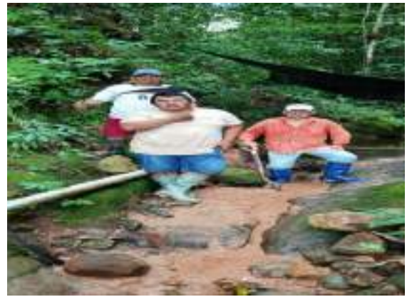
Figura 18: LIMPIEZA Y MANTENIMIENTO TOMA "CAMUY"
