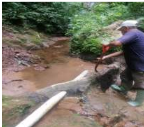
Figura 3: MANTENIMIENTO Y DESARENADO TOMA "RETIRO"
