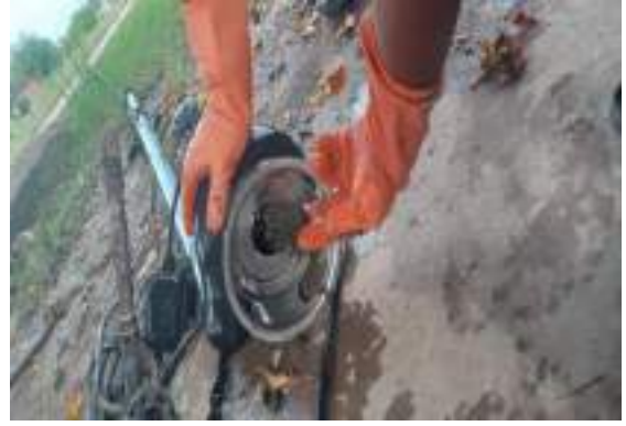
Figura 16: MANTENIMIENTO DE BOMBA DE AGUA EN "LOS AMBAIBOS"
