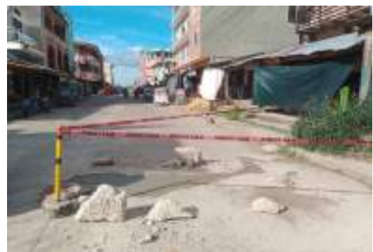
Figura 14: REPOSICION DE PAVIMENTO DE HORMIGO SIMPLE EN CALLE AVAROA.
