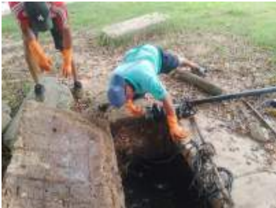
Figura 11: MANTENIMIENTO CARCAMO DE BOMBEO "LOS SAUCES".
