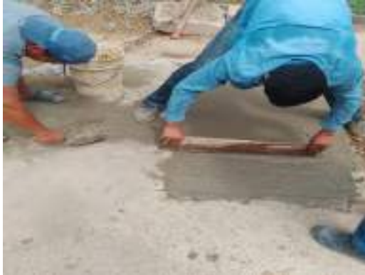
Figura 15: REPOSICION DE PAVIMENTO DE HORMIGON SIMPLE EN VILLA LOURDES.
